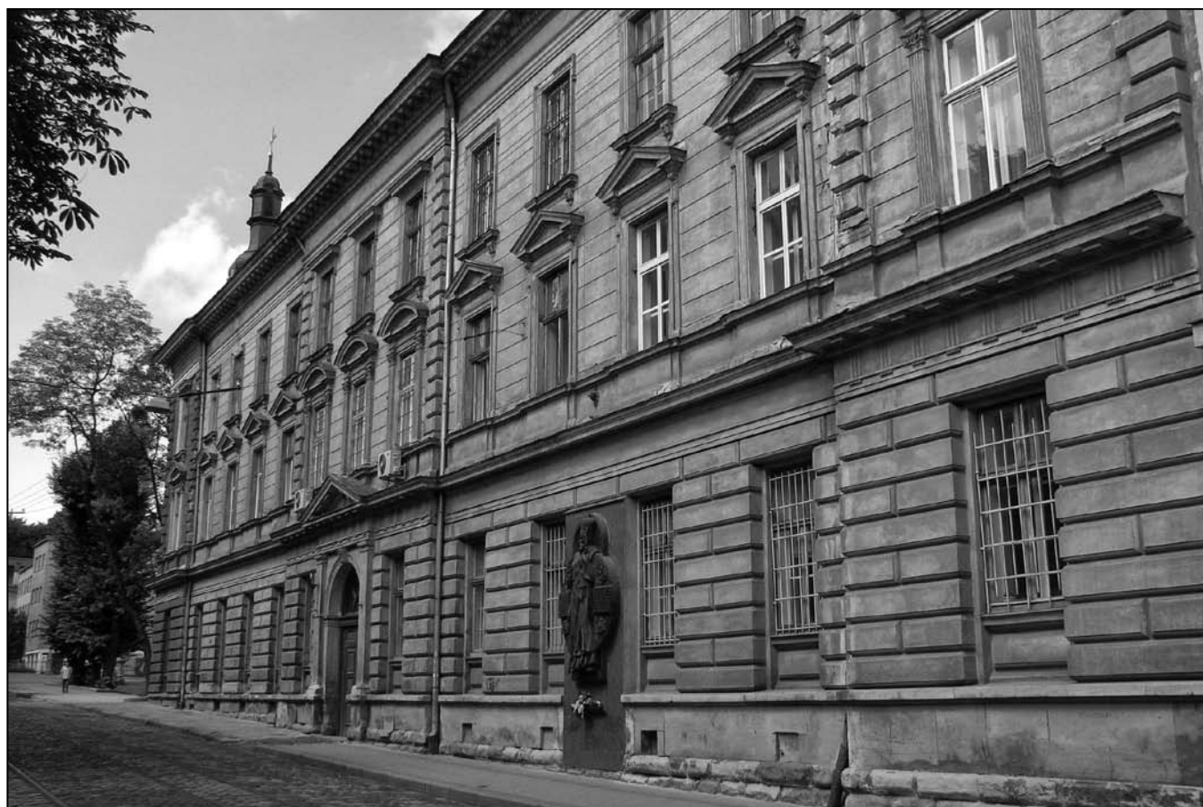
Будівля Греко-католицької Духовної семінарії та Богословської Академії у Львові; фасад з вул. Коперника, 36
